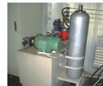
调速模块 —— HPU / Governor module —— HPU
